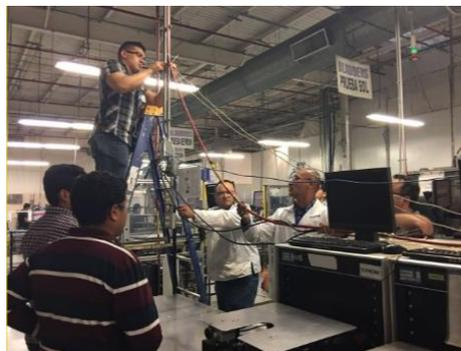
**Figura 8. Cambio de acometidas para el movimiento de equipos.**
