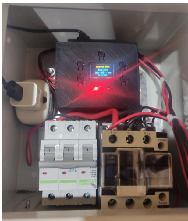
Figura 8. Gabinete del control de riego automático para huerto de cocos.
