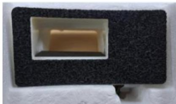
Figura 7. Ensamble del Gasket en el Damper.
