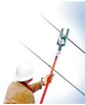
Figura 9 Toma de carga primaria
