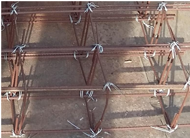
Figura 4. Nueva estructura de carga creada a partir del proceso descrito arriba.
